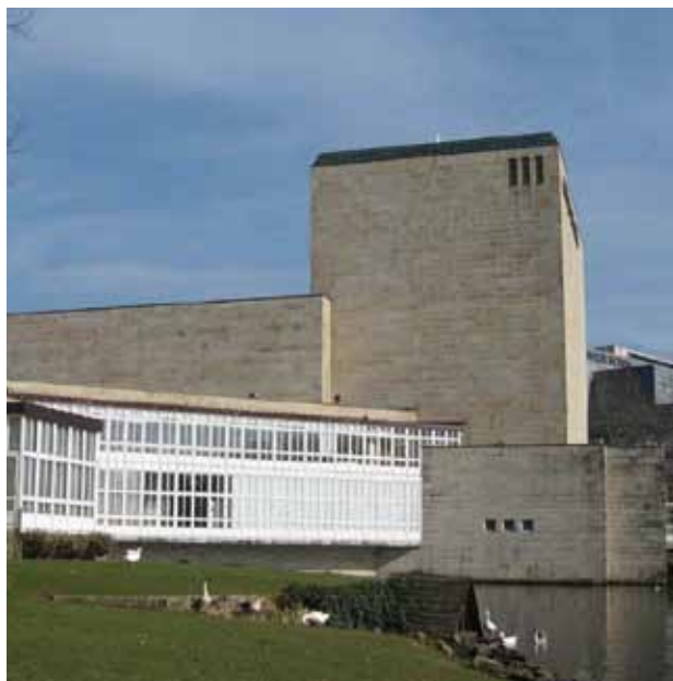
Las actuaciones en el Auditorio irán encaminadas a mejorar la seguridad del edificio
